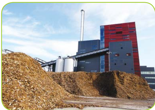
Abb. 8 Kraftwerk, das Nebenprodukte aus der Holzverarbeitenden Industrie als Brennstoff verwendet
