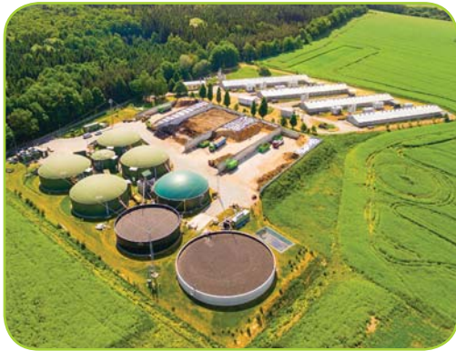
Abb. 7 Biogasanlage in der Tschechischen Republik
